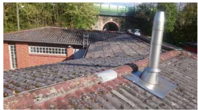
Der Kabinentrakt des Fußballvereins VFR Sölde vor der Sanierung mit einem Wellplattendach aus Asbestfasern.
