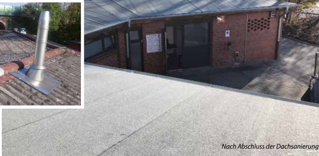
Der Kabinentrakt des Fußballvereins VFR Sölde vor der Sanierung mit einem Wellplattendach aus Asbestfasern.
