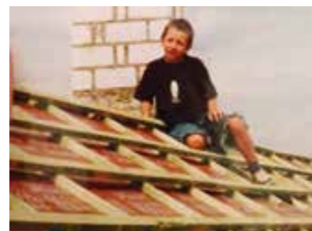
Hier auf dem Dach seines Großvaters Dachdeckermeister Günter Koschinski
