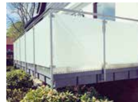
Balkonsanierung mit Geländerbau
