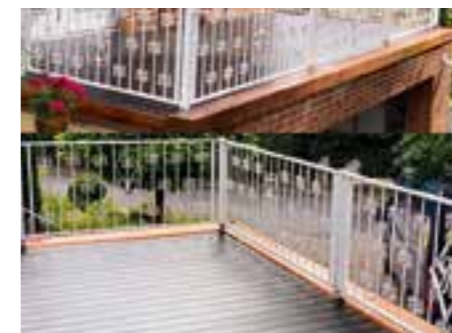
Balkonsanierung mit WPC-Terrassendielen
