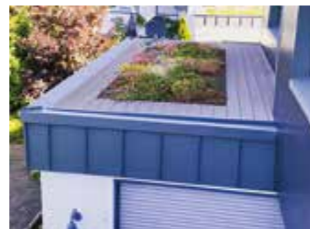
Kombinierte Flachdachabdichtung mit Gründachfläche
