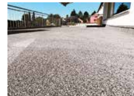
Balkonsanierung mit einem Granulat-Natursteinbelag
