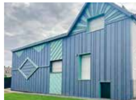
Fassadenbekleidung durch unsere Spengler-Fachkräfte
