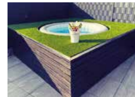
Terrassenbelag mit Errichtung einer Badestelle
