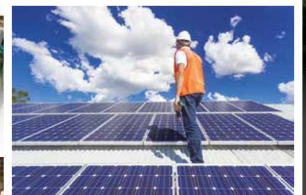
aubere Sache: Martin Schirba reinigt professionell Fenster und Gebäude sowie auch Ihre Photovoltaikanlage, ob für Privat oder Gewerbe.
