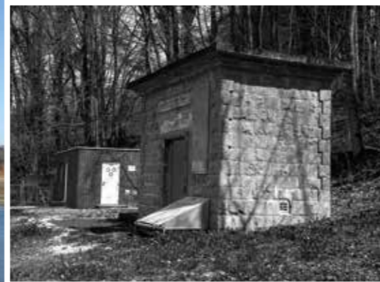
Die Lörmecke Wasserwerke beziehen ihr Wasser aus der gleichnamigen Quelle nahe Warstein. Foto: Lörmecke Wasserwerke
