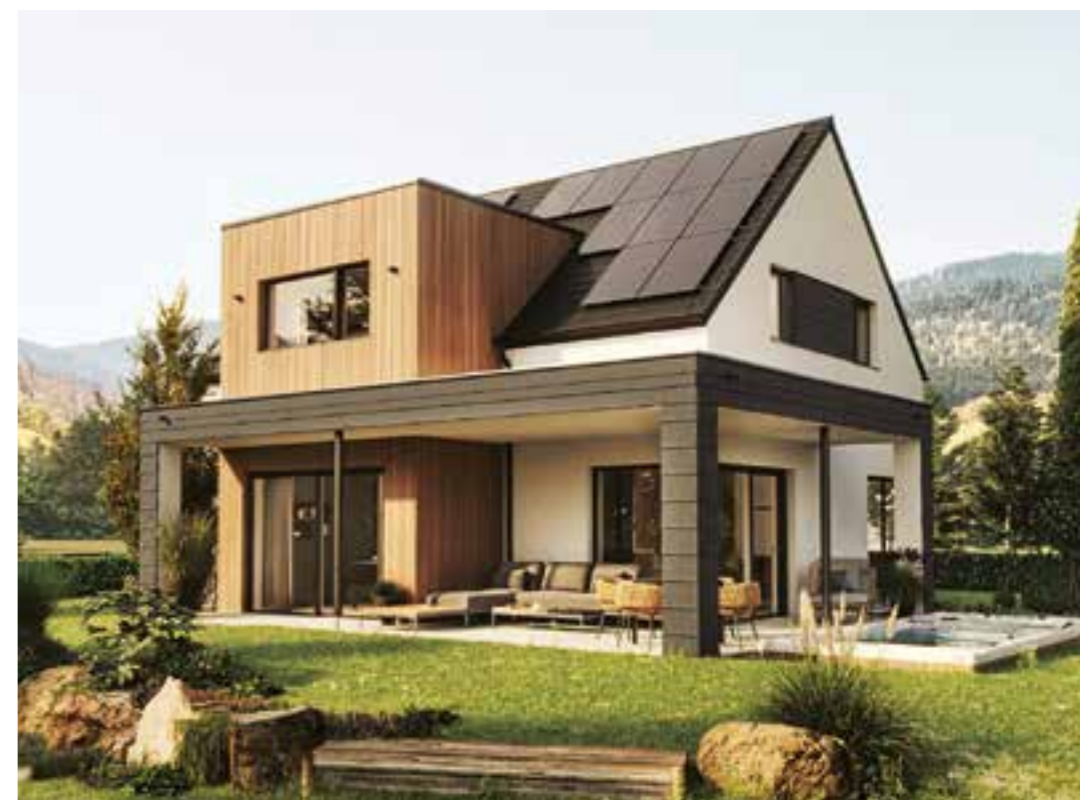
Dieses Plus-Energiehaus aus Holz gehört zu den 36 Finalisten im Wettbewerb um den Deutschen Nachhaltigkeitspreis Unternehmen 2023. Foto: HLC/KAMPA
