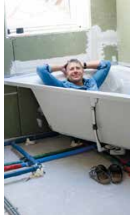
Der Sanierungsbedarf in vielen deutschen Häusern und Wohnungen ist hoch – wer die Modernisierung umfassend anpackt, darf mit hohen staatlichen Förderungen rechnen. Foto: DJD/BVR/Getty Images/Epiximages
